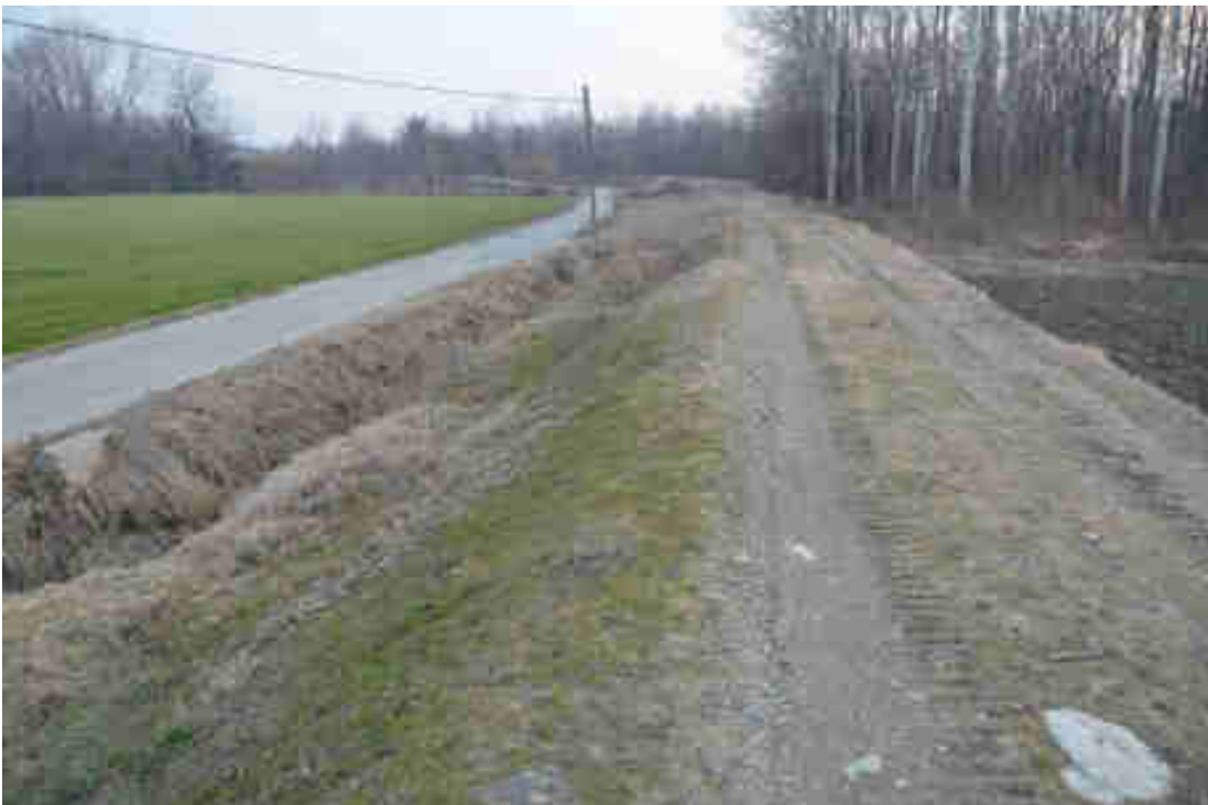
Figura 6 - Argine Baudenasca, loc. Agnesini.
