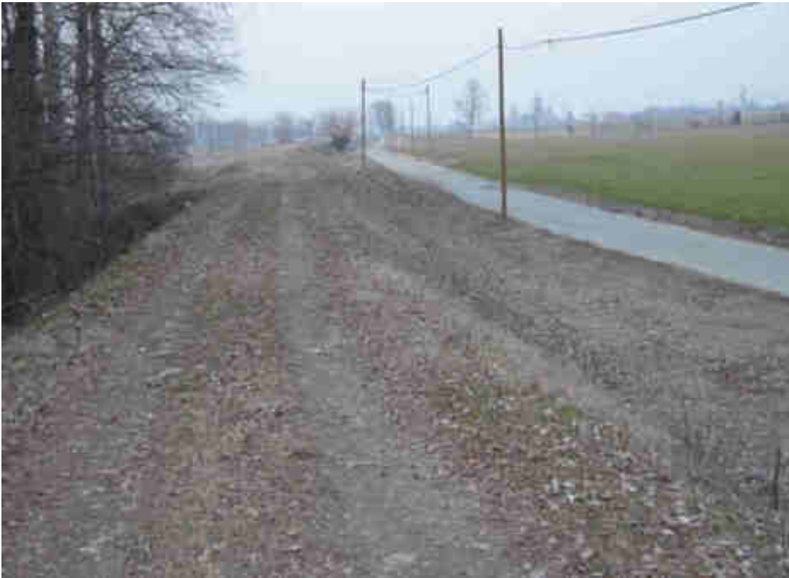
Figura 5 - Argine Baudenasca, loc. Agnesini.
